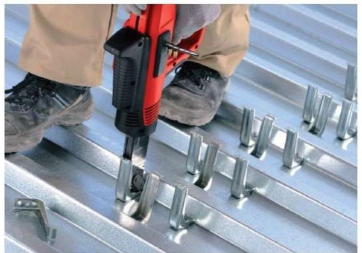
Conectores fijados mecánicamente
