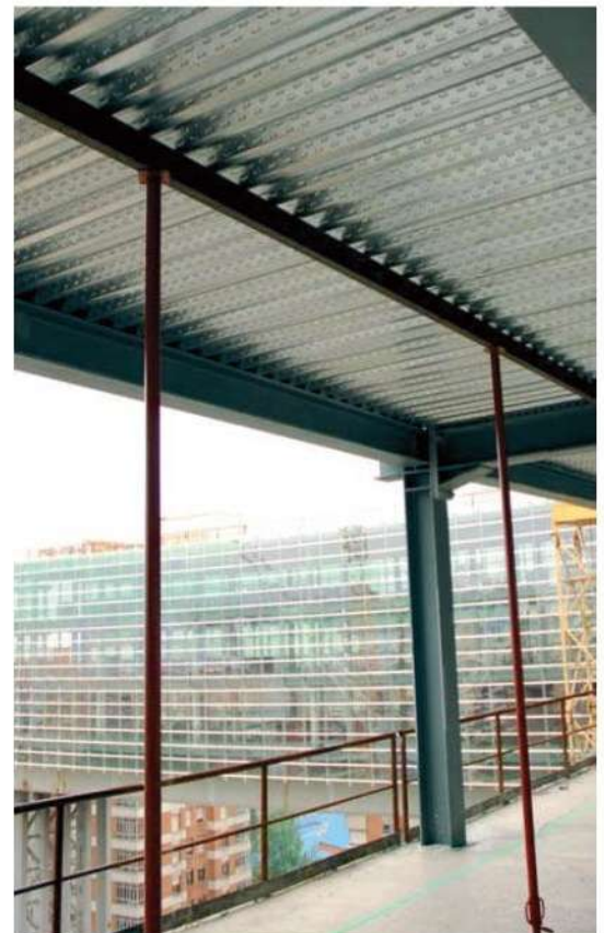
Imagen apuntalamiento provisional.
