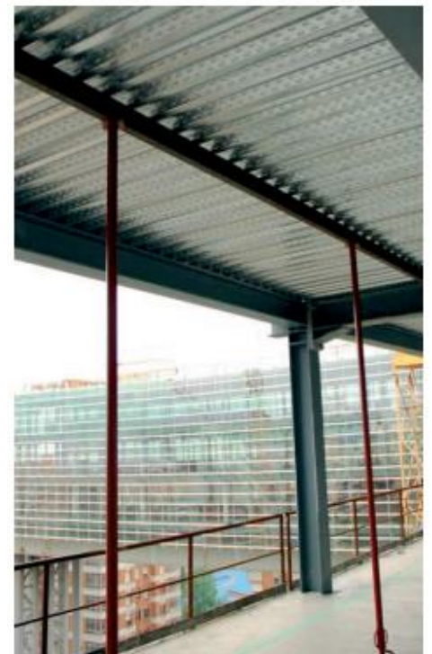
Imagen apuntalamiento provisional
