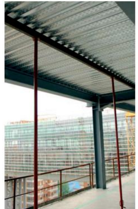
Imagen apuntalamiento provisional
