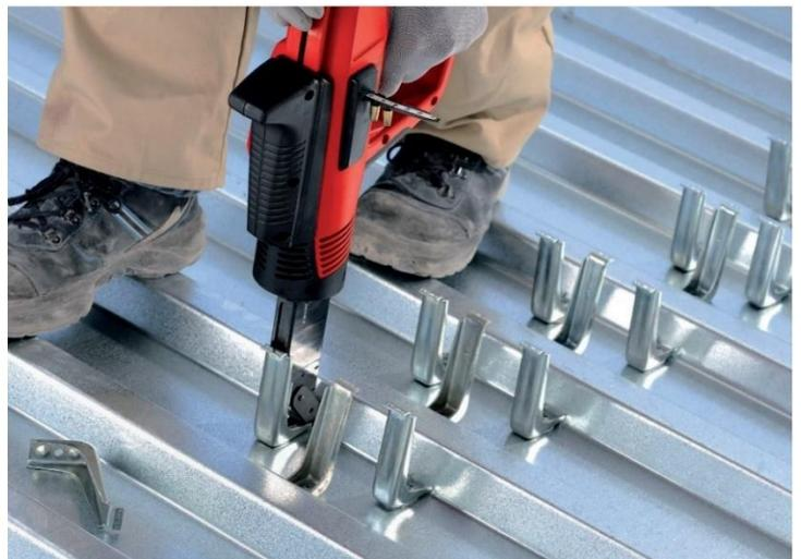
Conectores fijados mecánicamente
